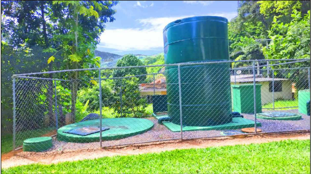
Figura 14 – ETE Alto do Recanto com capacidade de atender 500 habitantes
