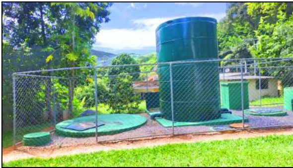
Fig. 14.1 ETE Alto do Recanto com capacidade de atender 500 habitantes
