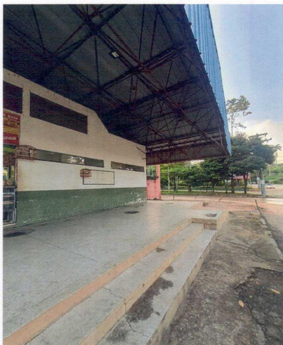
Figura 10: Fundos do Terminal Rodoviário, onde pode-se observar desgastes de pintura de paredes e da estrutura da cobertura, bem como patologias no piso e elementos de acessibilidade inadequados.
