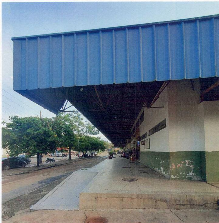
Figura 09: Frente do Terminal Rodoviário, onde pode-se observar desgastes de pintura de paredes e da estrutura da cobertura, bem como patologias no piso e elementos de acessibilidade inadequados.
