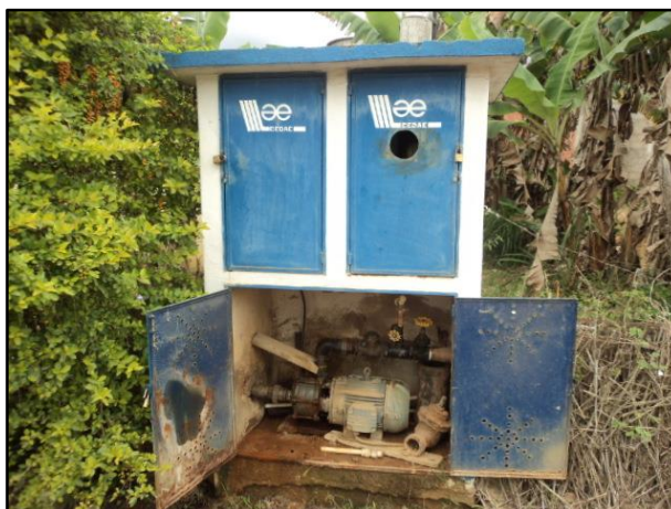
Figura 27 – Sistema de bombeamento
