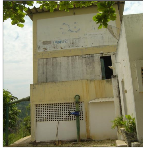
Figura 24 - Vista da ETA Avelar 2
