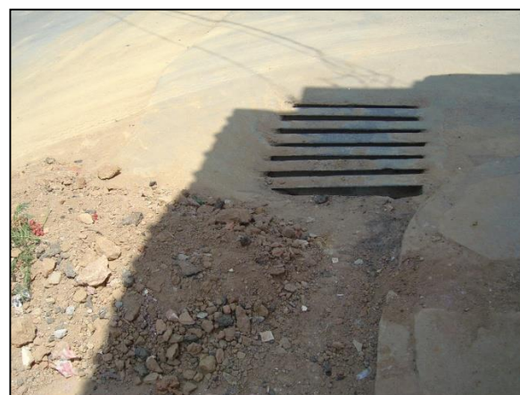
Figura 37 – Terra que estava obstruindo a boca de lobo
