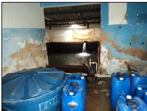
Figura 25 – Reservatório ETA Avelar
