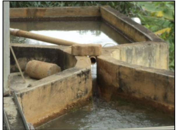
Figura 16 – Adição de agente coagulante
