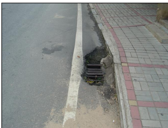
Figura 38 – Boca de lobo em péssimo estado de conservação 1
