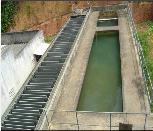
Figura 23 - Vista da ETA Avelar 1
